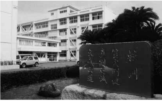
現在の正門からの耐震工事済みの校舎
