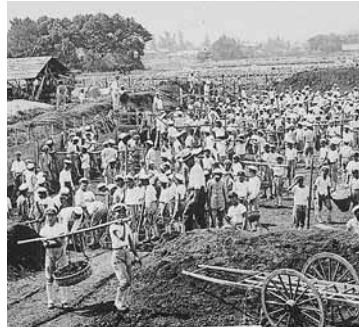
学校教育の一環 防風堤工事
