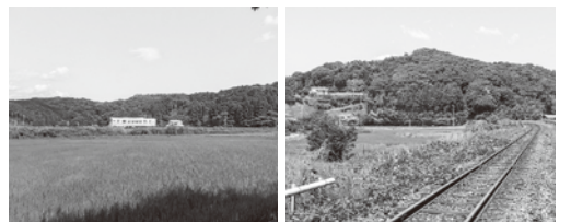
天竜浜名湖鉄道軌道として転用され、現在も使用されている(神田トンネル～神田公園前駅間)
