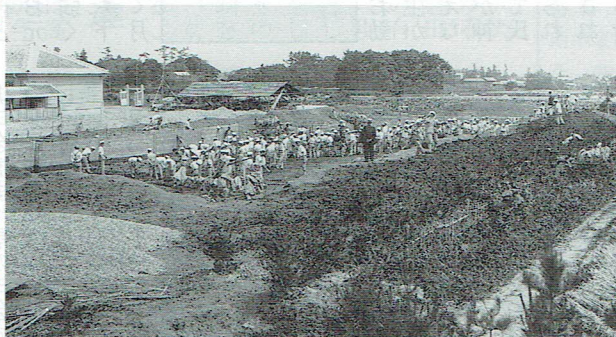
〔写真(上)新装プール(下)大正15年の建設風景〕
