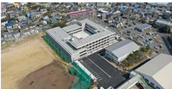
校地北東隅に建設された新校舎 南西方向上空から撮影(提供 石川建設)
